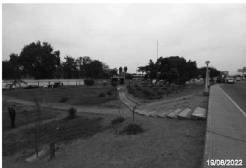
Vista de la sección vial de la Av. Faucett altura de la Av. La Chalaca del predio TE4-027,
